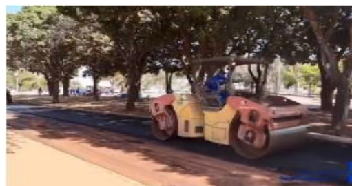
Recapamento da Avenida das Mangueiras
