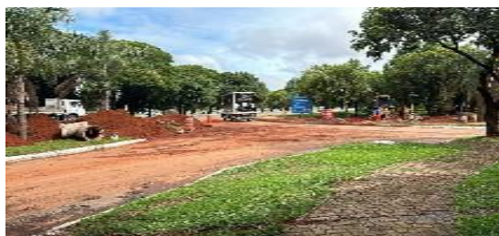
Drenagem Pluvial da Avenida nas Mangueiras
