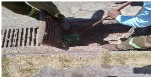
Limpeza e desobstrução de Bocas de Lobo
